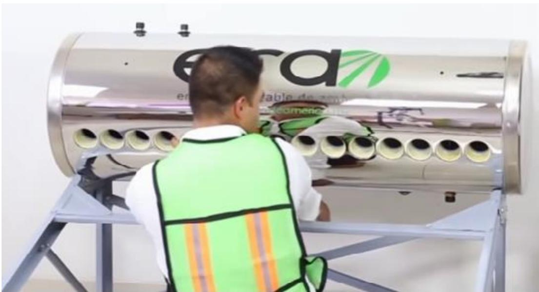
Se conectan los tubos al vacío con su empaque y con ayuda de jabón líquido disuelto en agua como lubricante.
