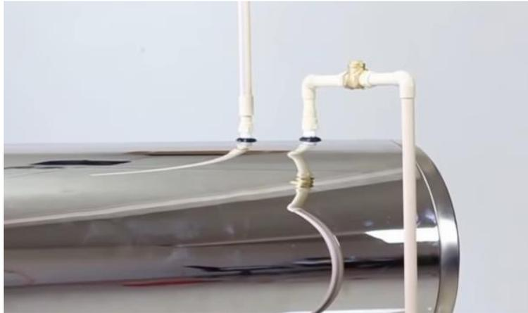
Se conecta la salida de agua con una llave para regular el paso de agua caliente hacia la llave de consumo o regadera.
