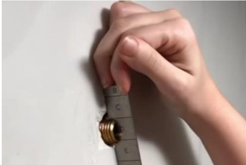
Se ensambla la estructura de la regadera neblia en el adaptador.
