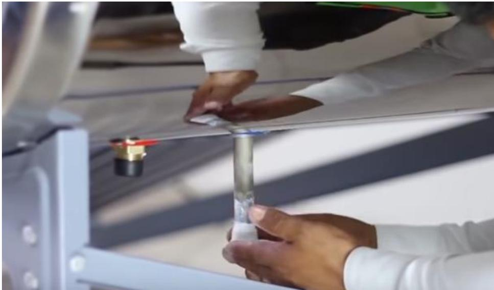
Se conecta la toma de agua del tinaco al termotanque del calentador con una llave de check que no permita su regreso al tinaco.
