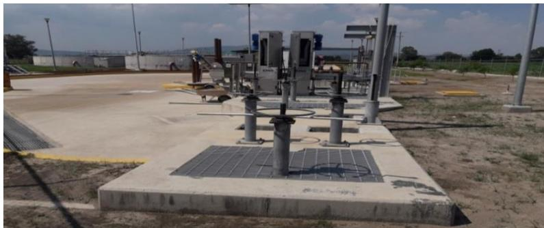
Figura 5. Desarenadores y cárcamo de bombeo PTAR
