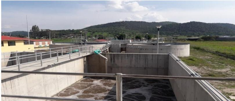
Figura 8. Tanques de Digestión Aeróbica
